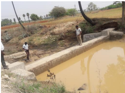
2016年 完成したチェックダム
