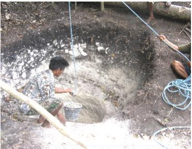
建設中の井戸
