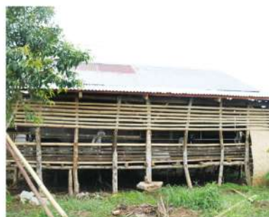
◀ 建設した有機肥料製造場
